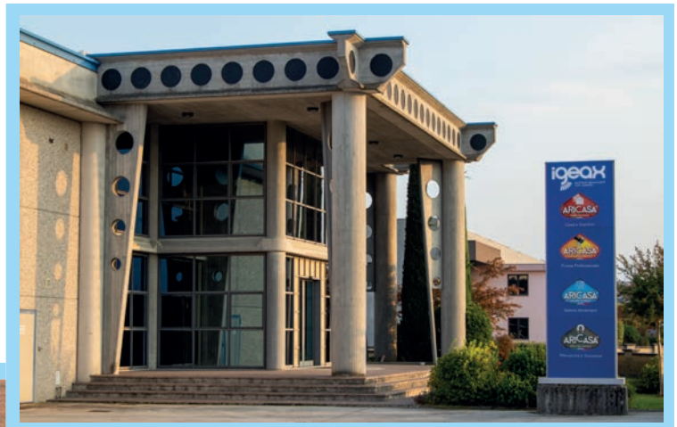
Ingresso uffici Office entrance
